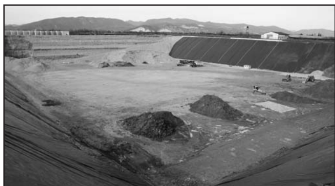
Gli ultimi lavori per la preparazione della discarica Gedit-Gabana.
